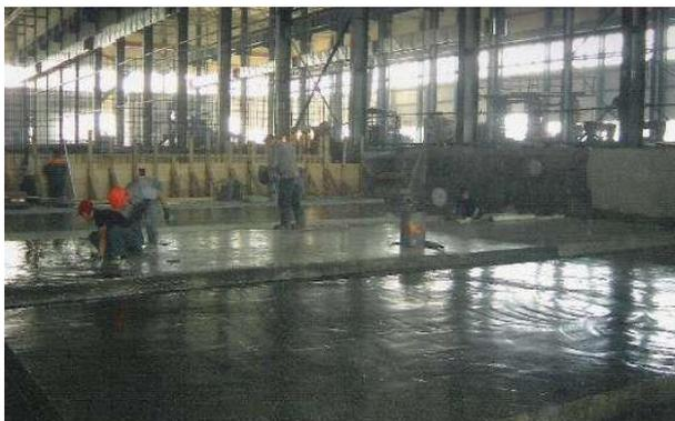
*Рис. 4. Защита поддонов ванн травления ламинатом «Ремохлор»*
