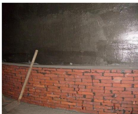
*Рис. 5. Емкость под пульпу NaCl-KCl защищённая ламинатом «Ремохлор»*
