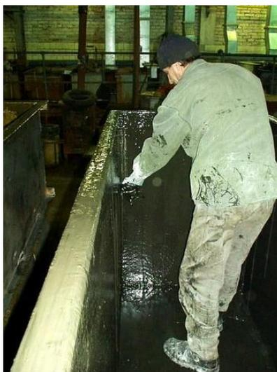
Рис. 2. Нанесение защитных материалов «Ремохлор» на ванну травления
