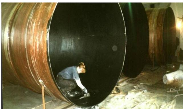
*Рис. 4. Защита газоходов ламинатом «Ремохлор»*
