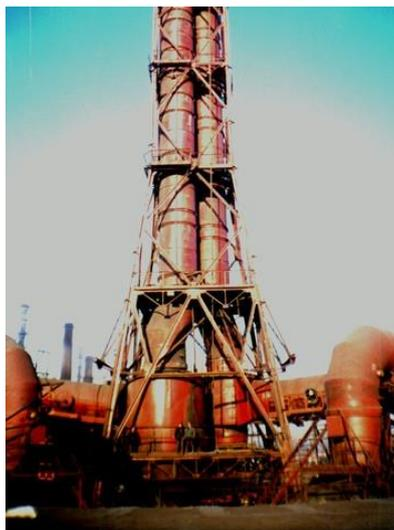
Рис.1. Система газоочистки из стеклопластика на ММК защищенной изнутри ламинатом «Ремохлор»
