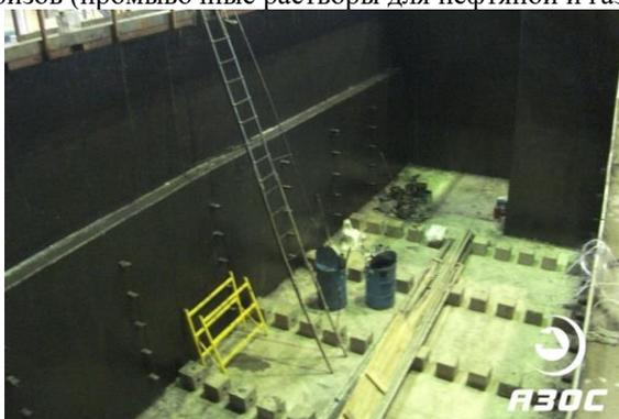
Рис. 3. Сборник травильных растворов полосового металла защищенных ламинатом «Ремохлор»
