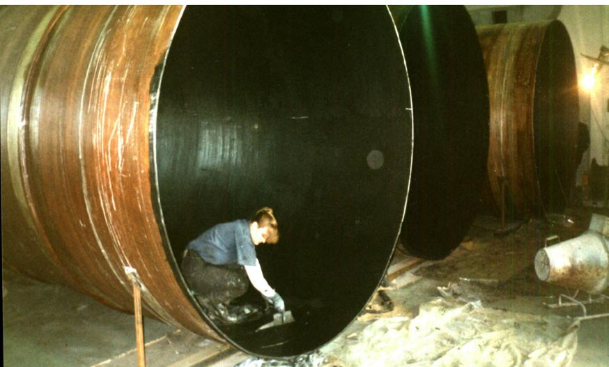
Нанесение покрытия «Ремохлор» на газоход из эпоксидного стеклопластика
