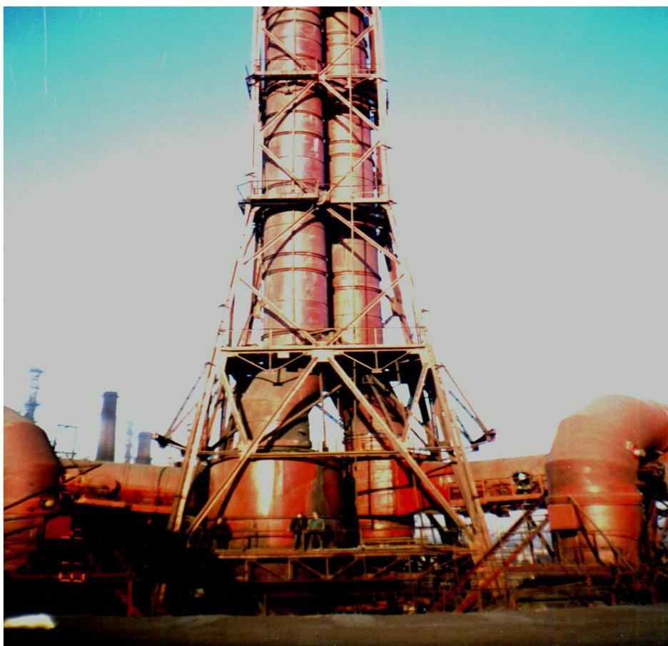
Система газоочистки (циклон) и выхлопная труба, защищенные покрытием «Ремохлор»
