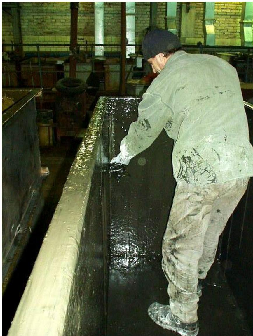
Нанесение защитного слоя на ламинат «Ремохлор-МБ» при защите гальванической ванны
