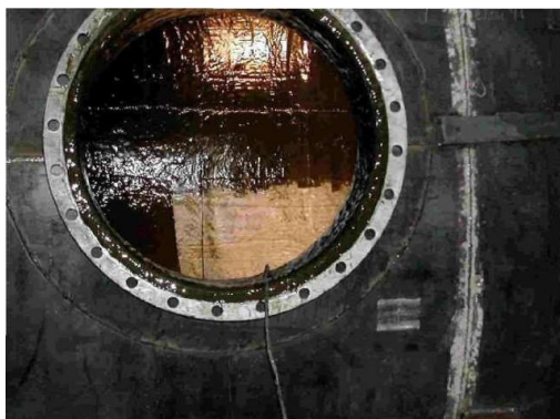
Рис 2. Защита емкости под соляную кислоту
