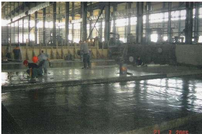
Рис 4. Защита поддонов материалами «Ремохлор». Защита от проливов горячей соляной или серной кислот.
