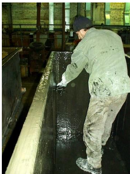
Рис. 1 Защита композитом «Ремохлор-У» гальванической ванны.
