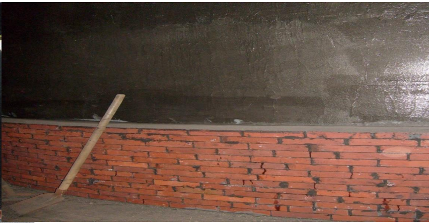
Рис. 4 Защита емкости под пульпу хлоридов с температурой 95-120°С композицией «Ремохлор-Т»(ЭФ)
