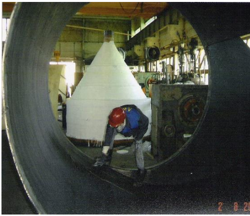
Рис.3 Защита газохода из стеклопластика, под горячие газы с температурой 90-105°С композицией «Ремохлор-Т»
